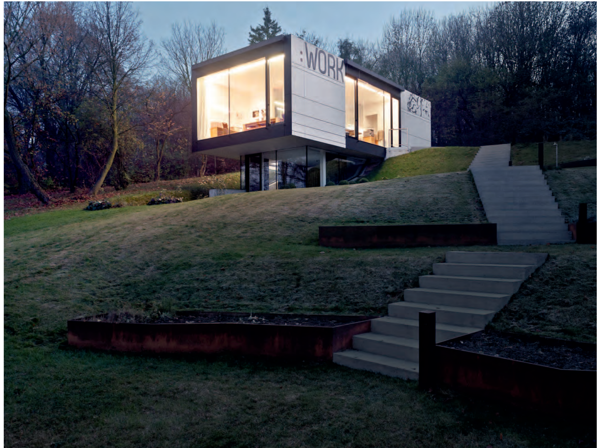
Smarthome: Am Stadtrand von Wien macht Matthias Horx die Probe aufs Exempel – und unterzieht neueste Haus- und Lichttechnik dem Praxistest.
